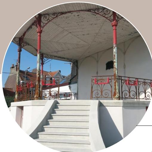
Réfection du toit, des bétons et des cimentages du kiosque. Projection d'un enduit et application d'une couche d'impression et de 2 couches de peinture. A venir : électricité, boiseries et peintures
